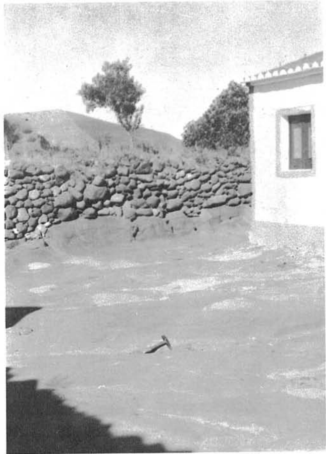
Fig. 2.21 – Arenitos vermelhos do Triásico (termo AB1) na povoação de Vale de Boi
