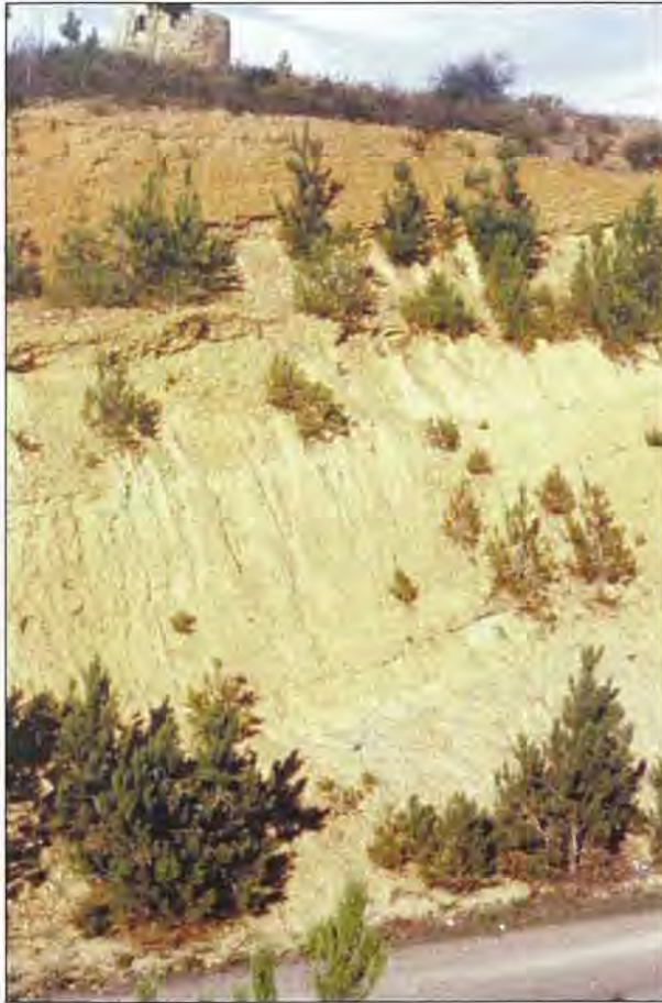
Fot. 2 - Vista geral do corte na estrada à saída de Aljezur para Monchique (W-E). São visíveis os xistos alterados e os depósitos grosseiros basais (amarelados na base e ferruginizados no topo), com a estratificação inclinando para W.
